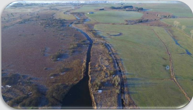
Reméandrement du Gouterot sur 500 m et restauration d'une passe à poissons – Bannans (25)
